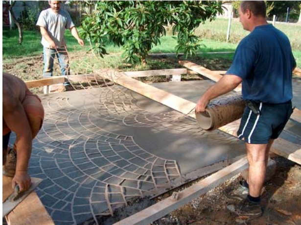
MISE EN PLACE DE LA TRAME SUR LA DALLE FRAICHE
