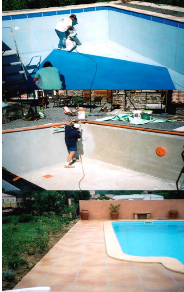
REALISATION D'UN INTERIEUR DE PISCINE ET DE SA PLAGE
