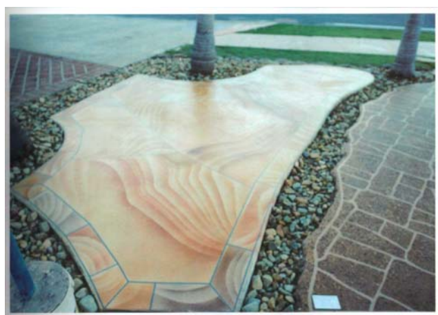
TRAVAIL DE DECORATION AVEC POSE D'AHESIFS A GAUCHE ET TRAME LONDON A DROITE
