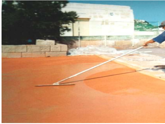
TALOCHAGE DES DURCISSEURS SUR LA DALLE FRAICHE
