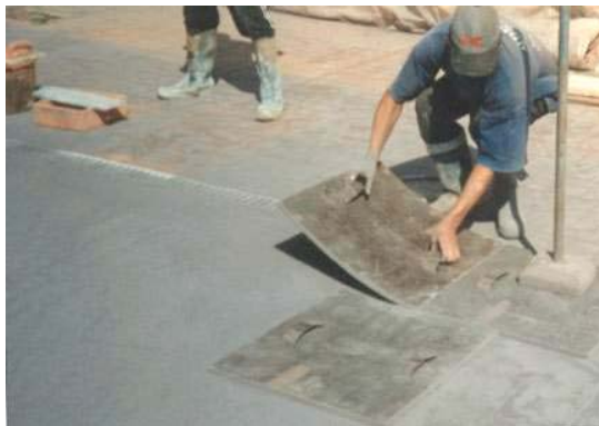
MISE EN PLACE DES EMPREINTES TYPE DALLES
