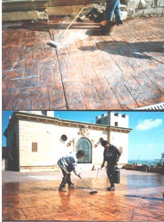
LAVAGE LE LENDEMAIN ET PASSAGE D'UNE RESINE DE PROTECTION
