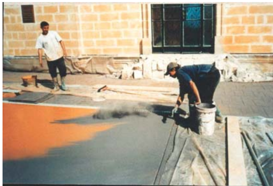
POUDRAGE DU DEMOULANT
